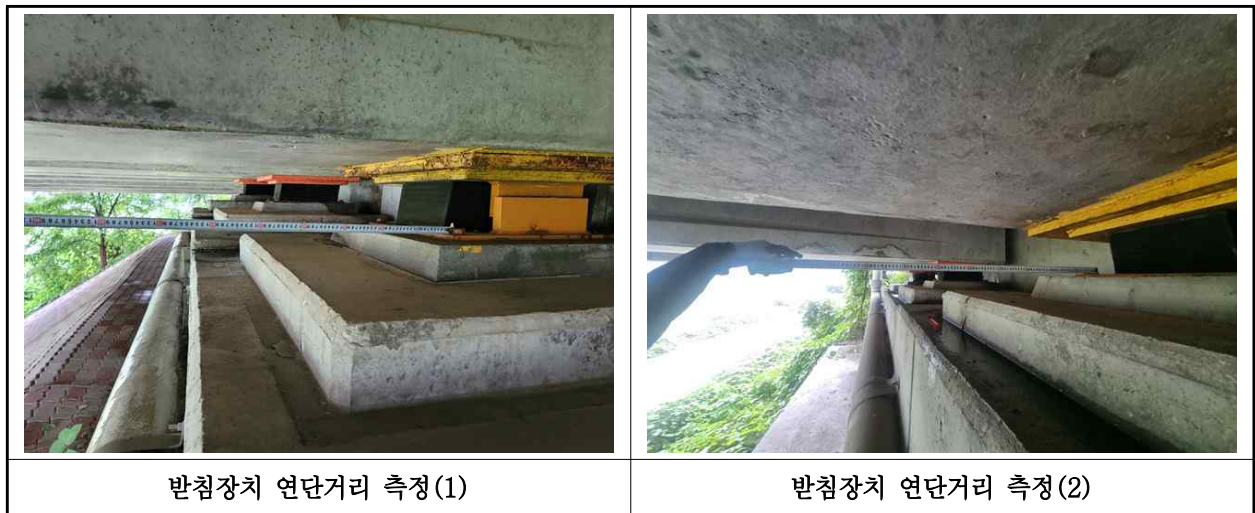
【사진 17.3.15】 교량받침장치 연단거리측정
