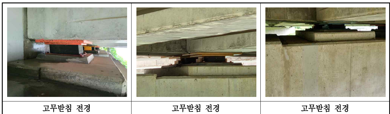
【사진 17.3.13】 교량받침 전경
