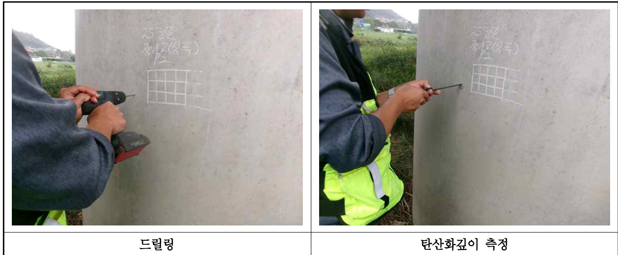
【사진 17.4.3】 탄산화 깊이 측정 현장사진
