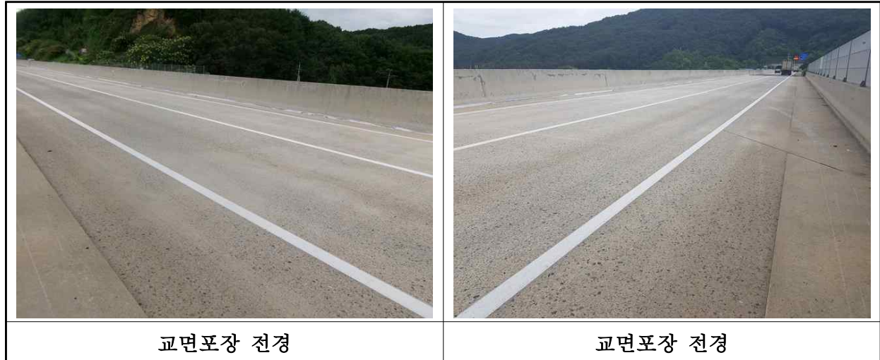
【사진 17.3.20】 교면포장 전경
