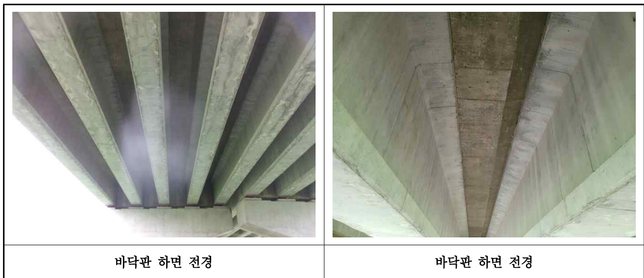
【사진 17.3.2】바닥판하면 전경
