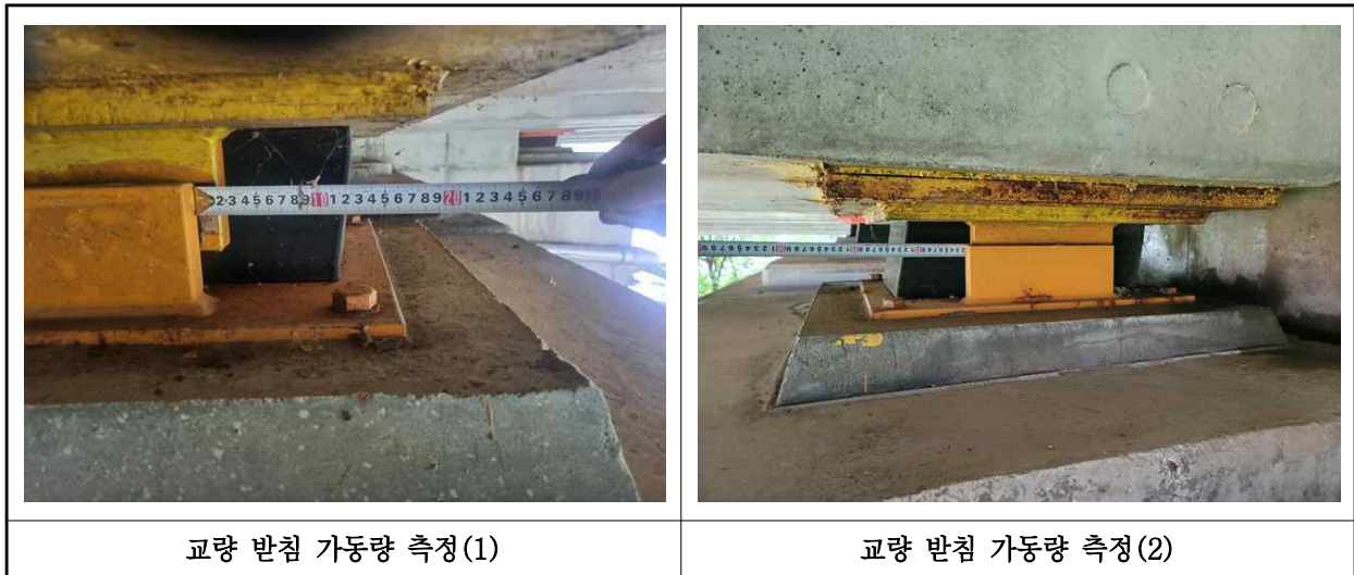
【사진 17.3.16】 교량받침 이동량 측정
