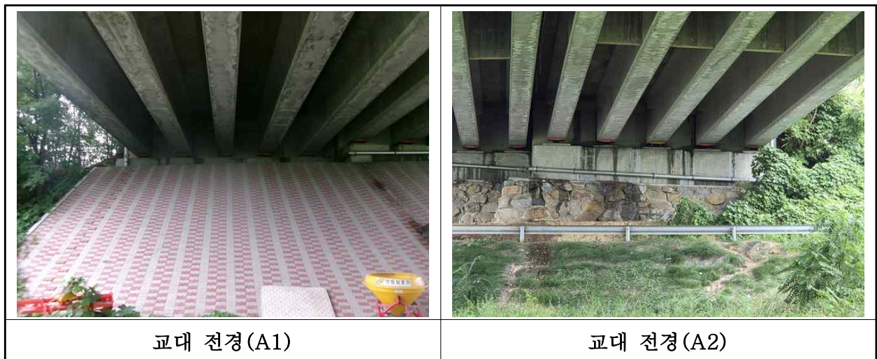
【사진 17.3.33】 교대 전경
