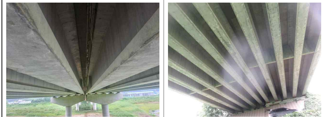
중분대 하면 상태양호
