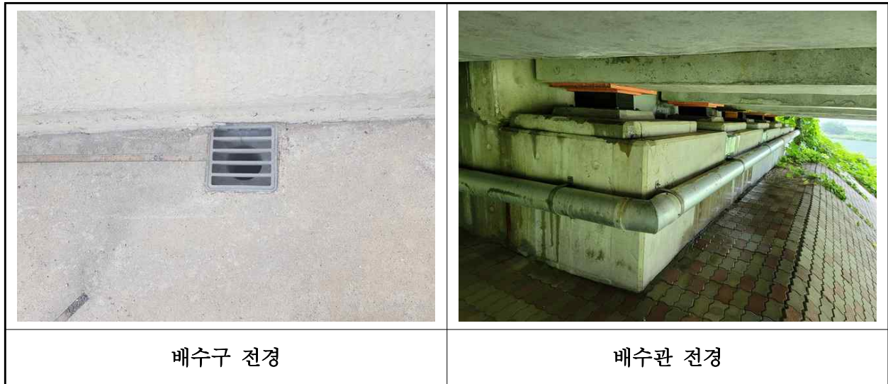
【사진 17.3.22】 배수시설 전경
