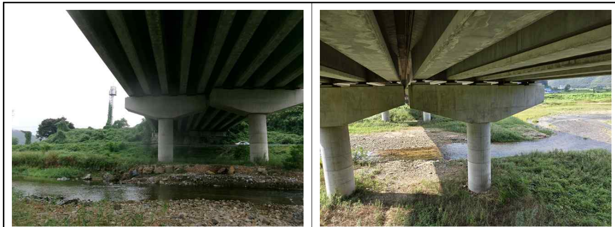
교각 코핑부 상태양호
