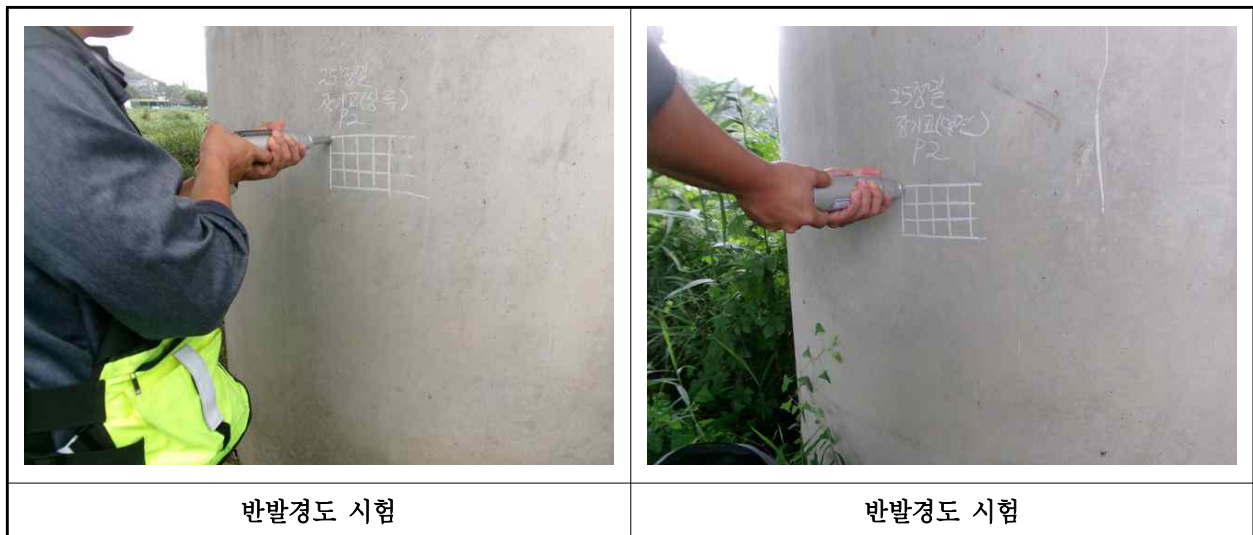
【사진 17.4.2】 반발경도시험 현장사진
