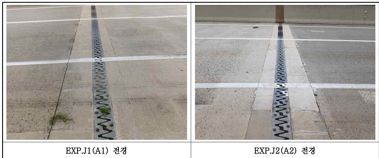
【사진 17.3.42】 신축이음장치 전경
