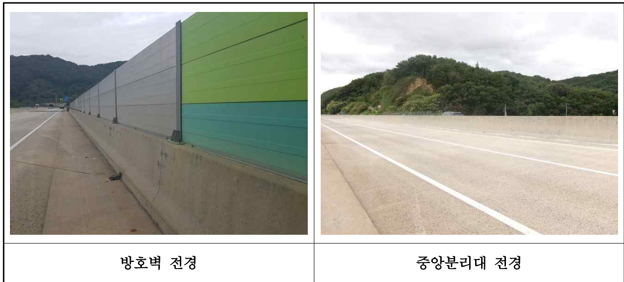
【사진 17.3.24】 방호벽 및 중앙분리대 전경
