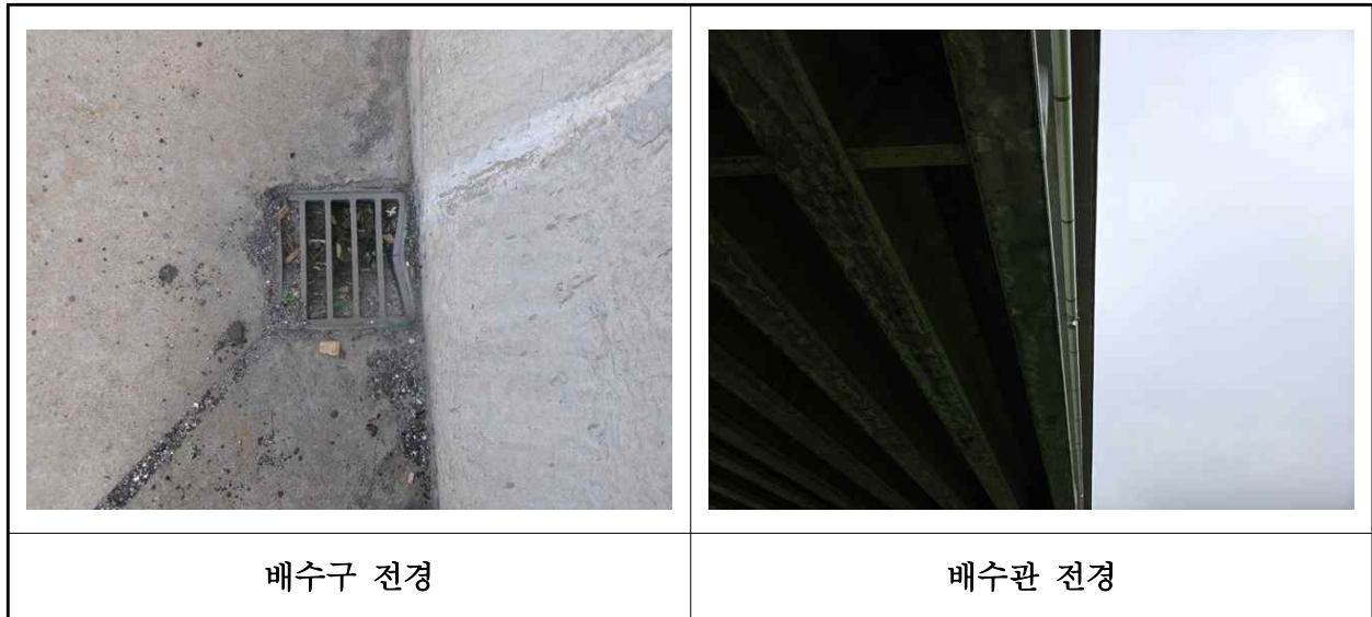
【사진 17.3.47】 배수시설 전경
