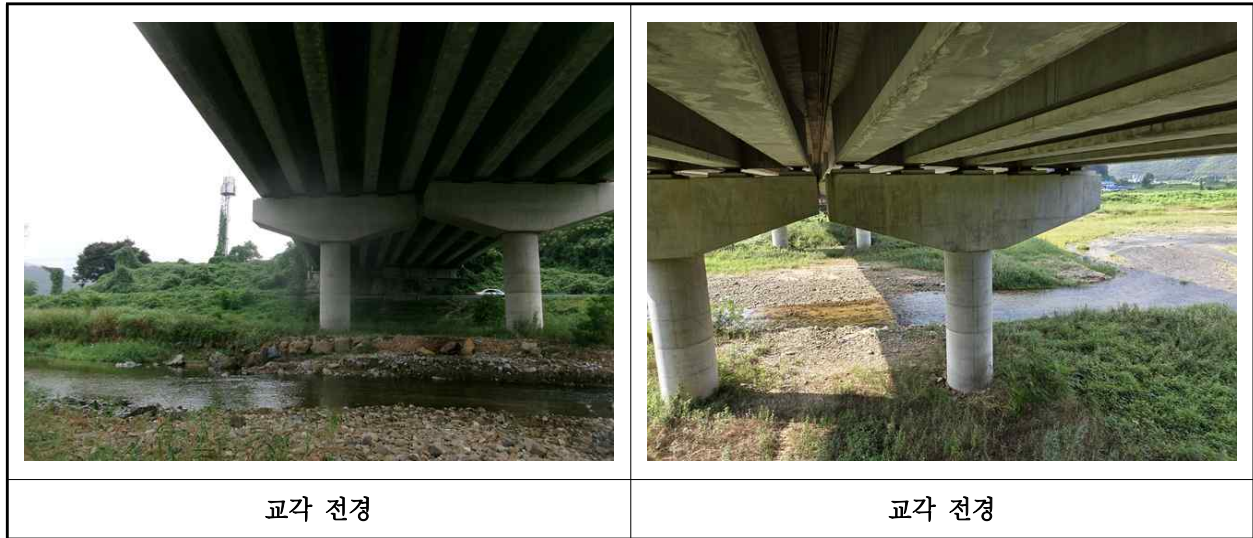
【사진 17.3.10】 교각 전경
