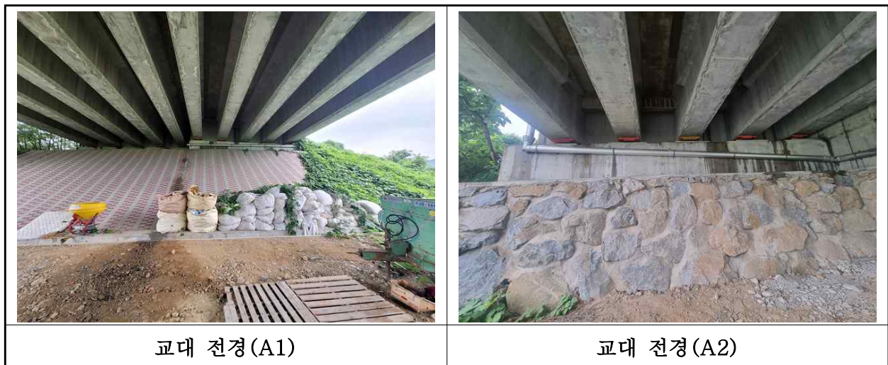
【사진 17.3.8】 교대 전경
