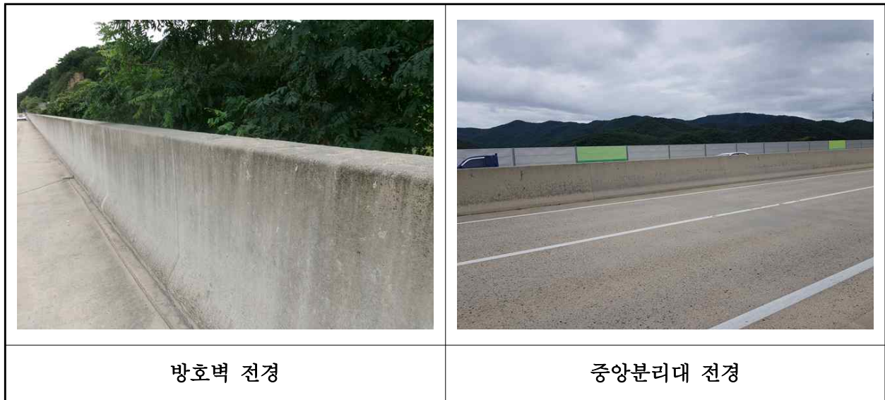
【사진 17.3.49】 방호벽 및 중양분리대 전경
