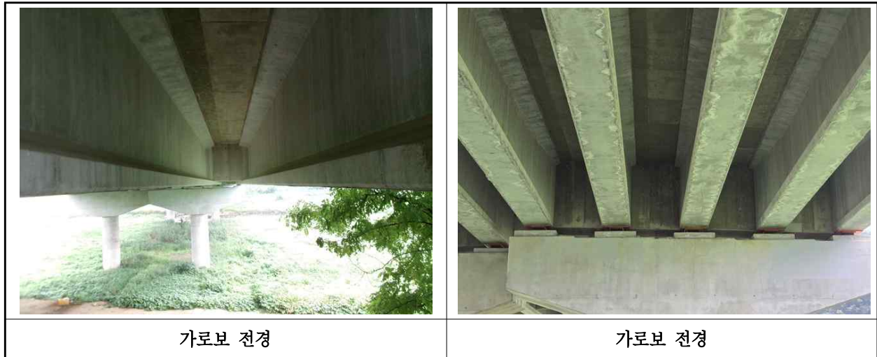
【사진 17.3.31】 가로보 전경
