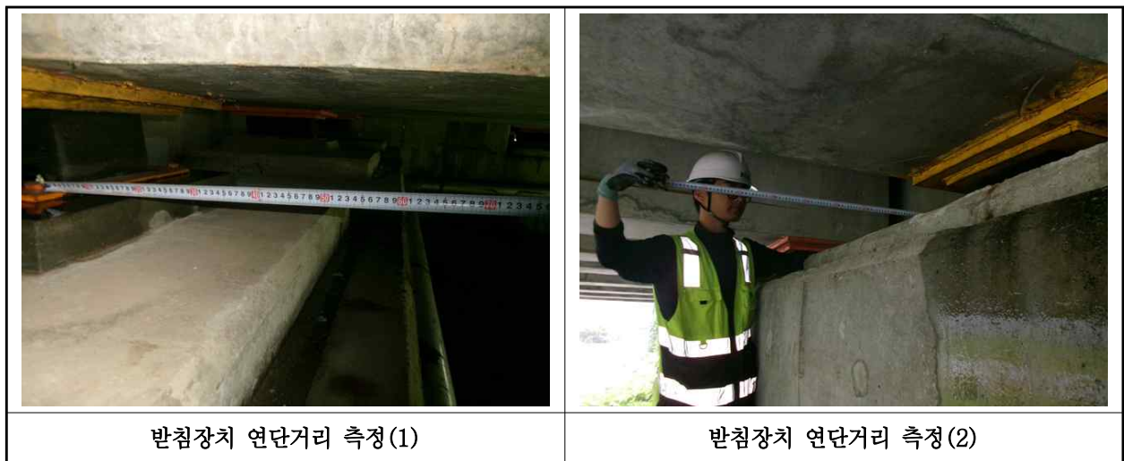
【사진 17.3.40】 교량받침장치 연단거리측정
