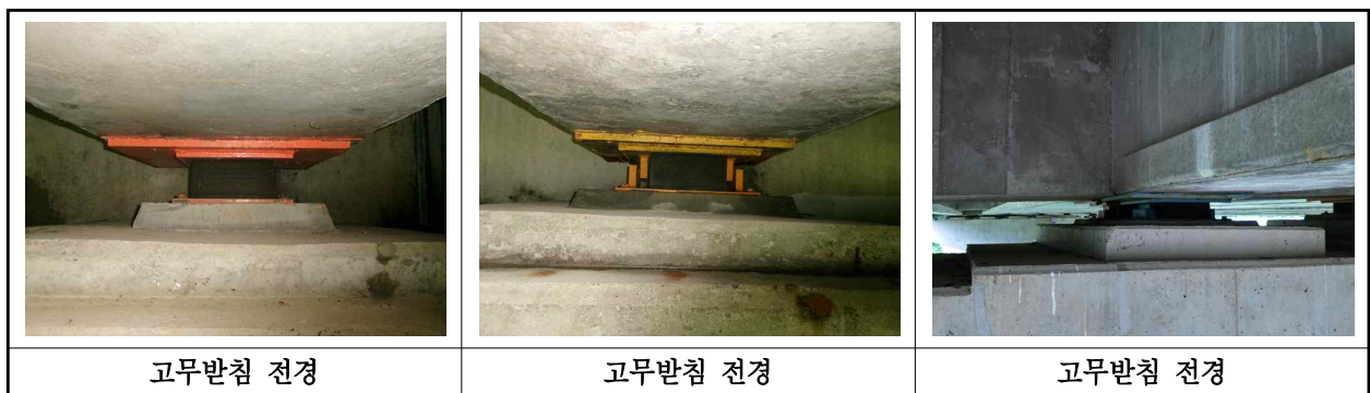
【사진 17.3.38】 교량받침 전경
