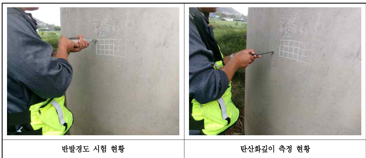
【사진 17.4.1】 콘크리트 내구성조사 현황
