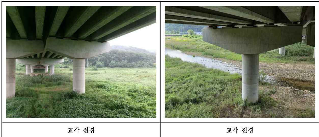
【사진 17.3.35】 교각 전경
