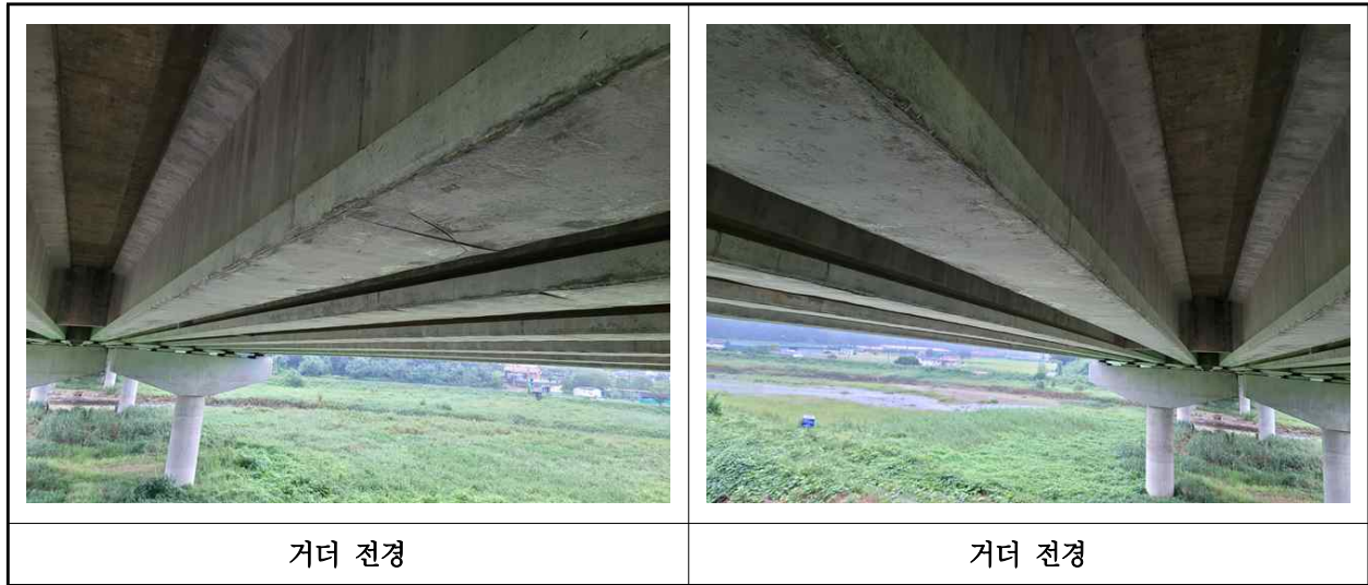
【사진 17.3.4】 거더 전경
