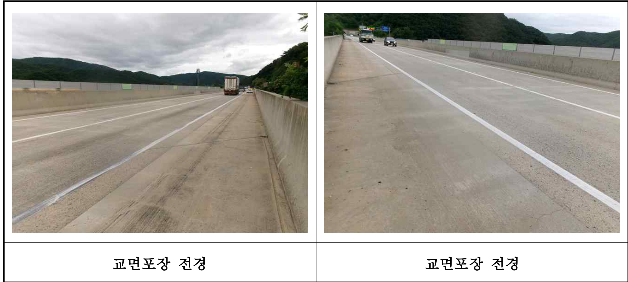
【사진 17.3.45】 교면포장 전경
