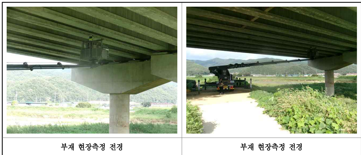
【사진 17.2.1】 부재 현장측정 전경
