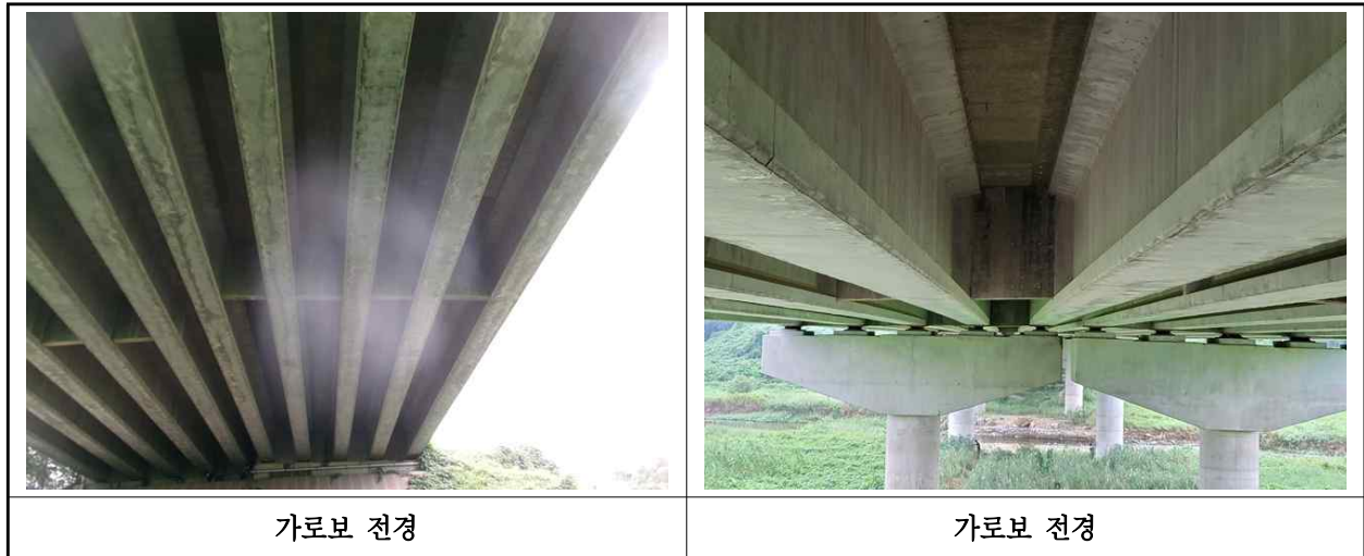
【사진 17.3.6】 가로보 전경
