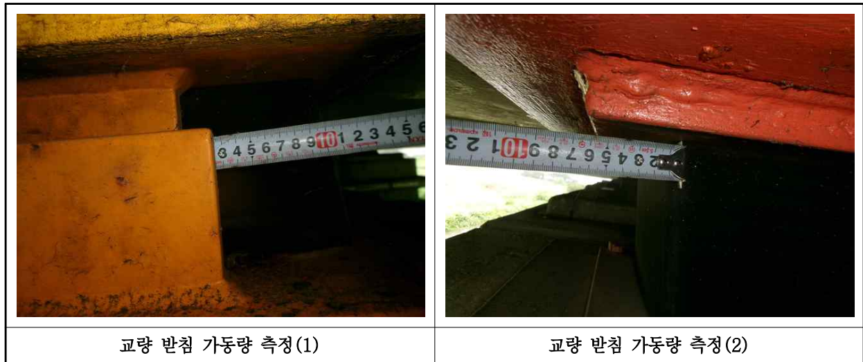
【사진 17.3.41】 교량받침 이동량 측정
